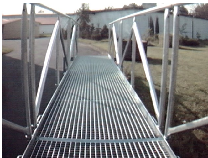
obr. 2 pohled na mostovku prototypu havarijní lávky „HL3“
